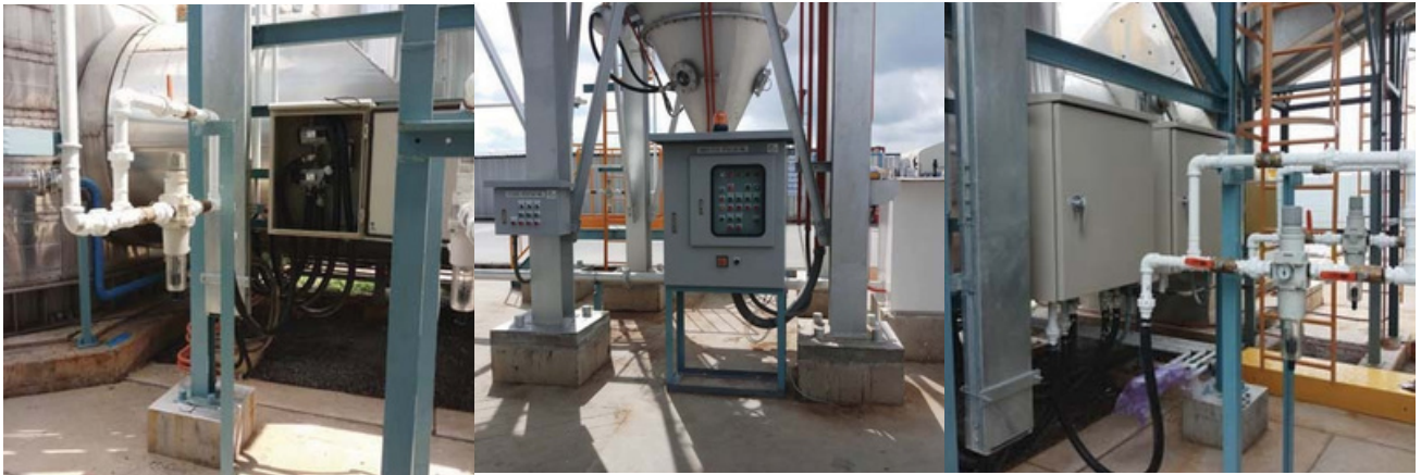
Customer : UACJ (Thailand) Co., Ltd. งานวางระบบและติดตั้งเครื่อง Dust Collector
