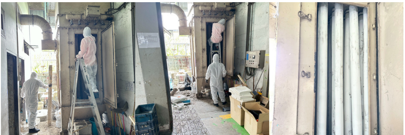
Customer : THAI UNITED PLASTIC INDUSTRY CO., LTD. งานเปลี่ยนถ่วงกรอง Bag Filter สั่งตัดเฉพาะ เครื่อง Dust Collector
