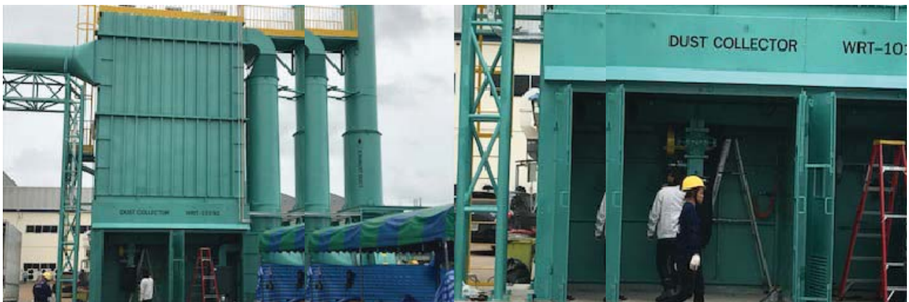
Customer : Nissin Brake (Thailand) Co., Ltd. งานวางระบบและติดตั้งเครื่อง Dust Collector System
