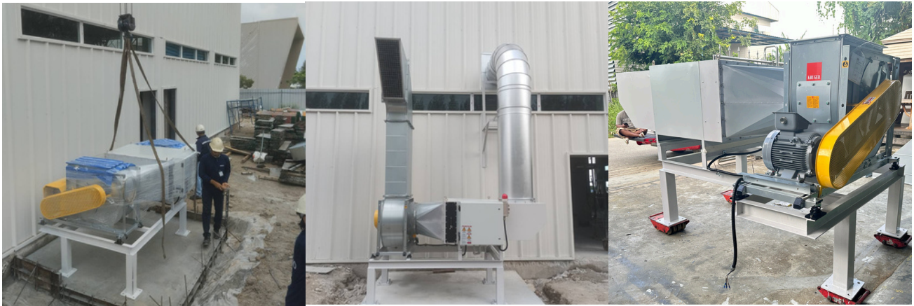
งานออกแบบและติดตั้งเครื่อง Oil Mist Collector ให้กับ ปตท. ระยอง
