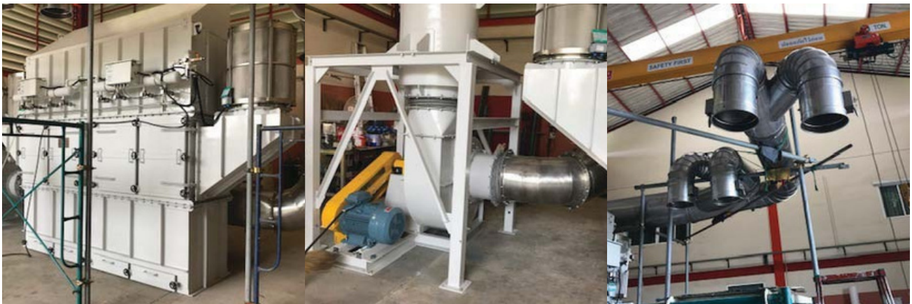
Customer : Mondelez International (Thailand) Co., Ltd. งานออกแบบสร้างและติดตั้งเครื่อง Dust Collector System
