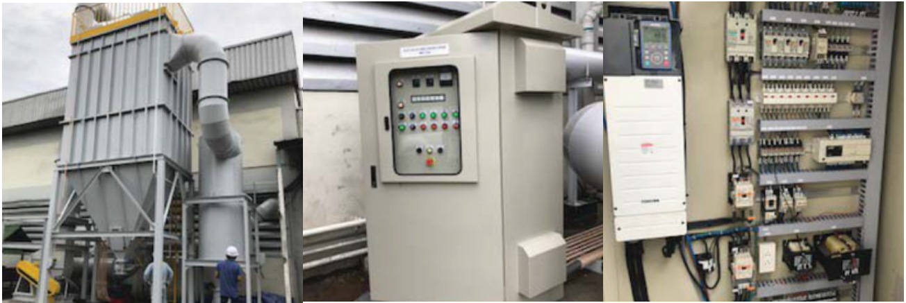
Customer : NGK Ceramics (THAILAND) Co., Ltd. งานวางระบบและติดตั้งเครื่อง Dust Collector System
