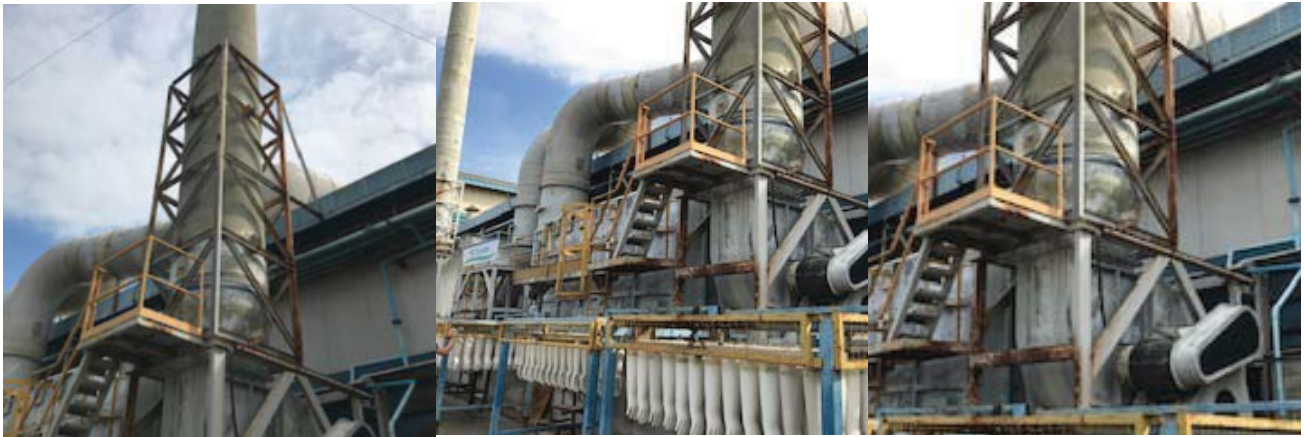
Customer : Ansell (Thailand) Co., Ltd. งานวางระบบและติดตั้งเครื่อง Wet Scrubber และ Maintenance job
