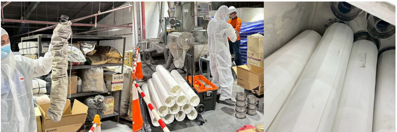
Customer : TOA PERFORMANCE COATING CORPORATION CO.,LTD. งานแก้ไข ปรับปรุง และติดตั้งลูกกรองใหม่เครื่อง Dust Collector
